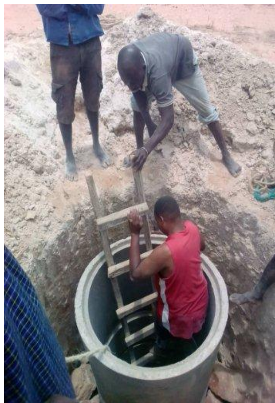
Posizionamento dei cilindri di cemento del pozzo di Nholi.
